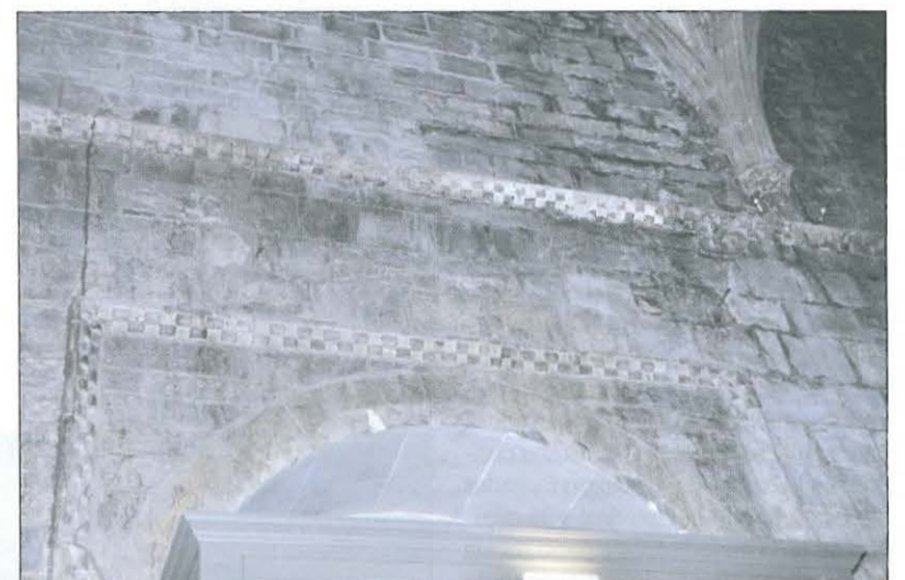
El alfiz ajedrezado y un arco de medio punto que estaban ocultos tras la puerta interior de la lonja sur
