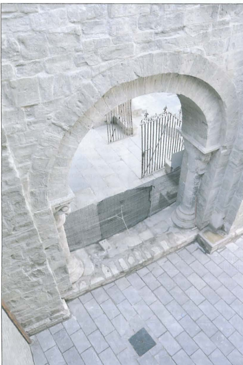
Vista del arco liberado desde el acceso a la torre
