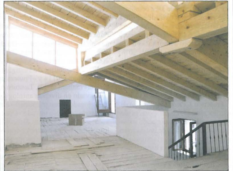
Interior del ático en el edificio anexo, desde el que se accede a la linterna y la torre
