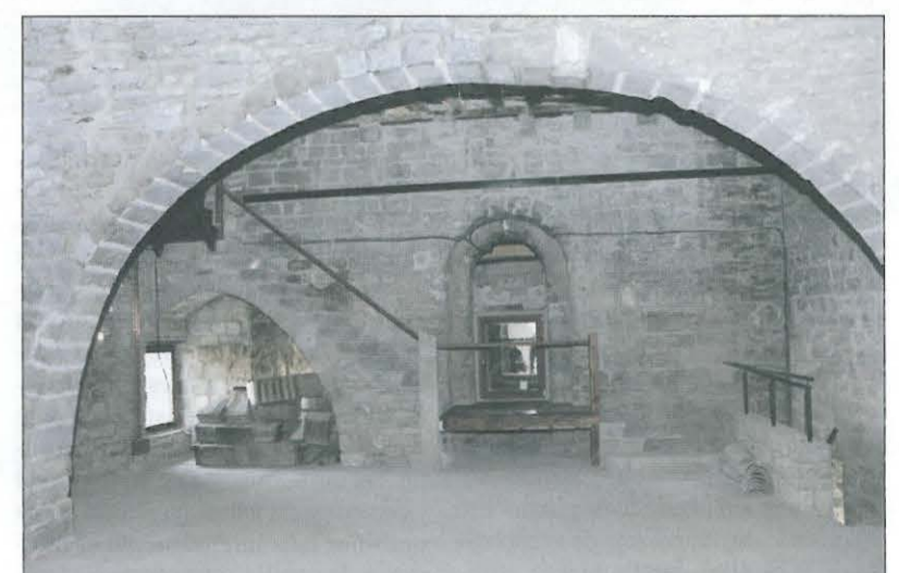
Interior de la torre tras la restauración
