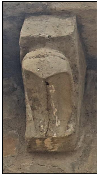
8.- Canecillo nave central, muro sur
