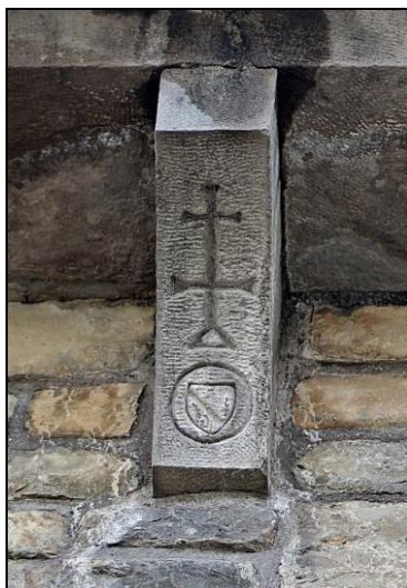
1.- Canecillo del alero de la fachada principal
