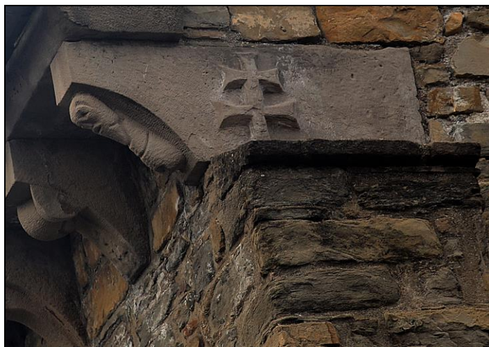
2.- Lateral del canecillo del alero la fachada principal
