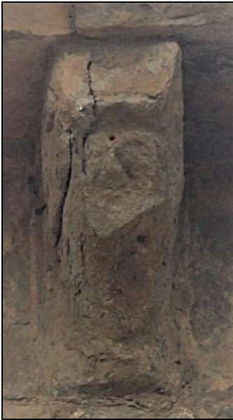
7.- Canecillo nave central, muro sur
