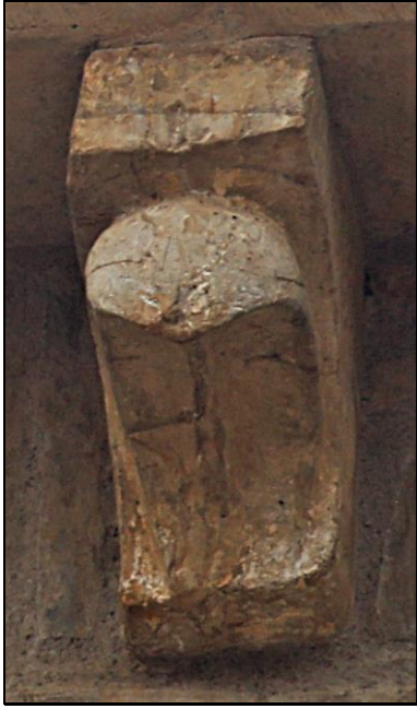
5.- Canecillo de la nave central, muro sur
