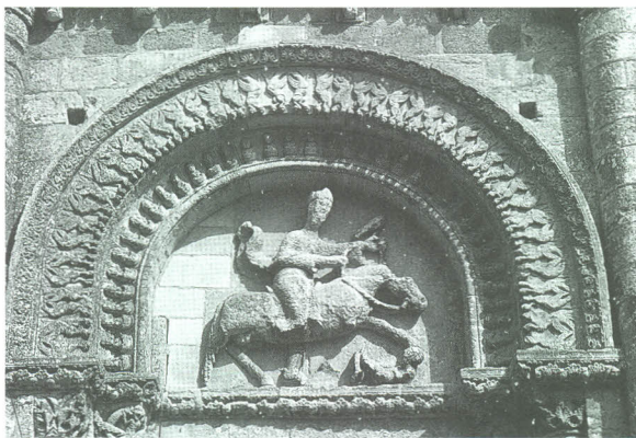
Saint-Pierre de Parthenay-le-Vieux. Fachada Oeste.
