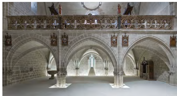
El interior del sotacoro se organiza mediante tres amplios tramos de bóveda de crucería. Destaca su vista frontal, con el enorme desarrollo del coro alto, enriquecido por la balconada de tracerías lobuladas y los dos ángeles-atriles.
