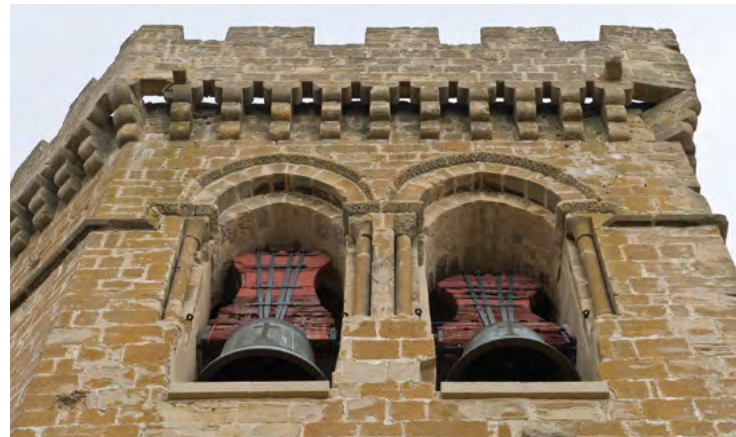
En la parte superior, vista general del exterior de los ábsides románicos, desde el sur. Sobre estas líneas, remate de la torre mayor, con sus matacanes y almenas. Para los huecos del campanario se reutilizaron dos enmarques de ventana labrados probablemente en el primer tercio del siglo XIII. En la página contigua, puerta románica reutilizada como ventana del nivel intermedio de la torre.
