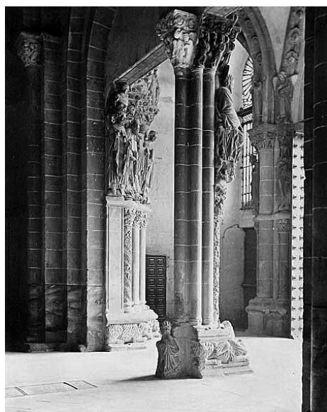
Fig. 4. T. Thompson. Vista desde el interior. Pórtico de la Gloria.
