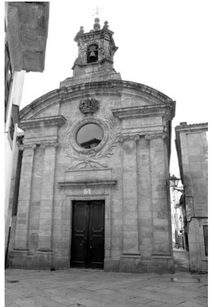
Fig 4.- Santa María del Camino: fachada.
