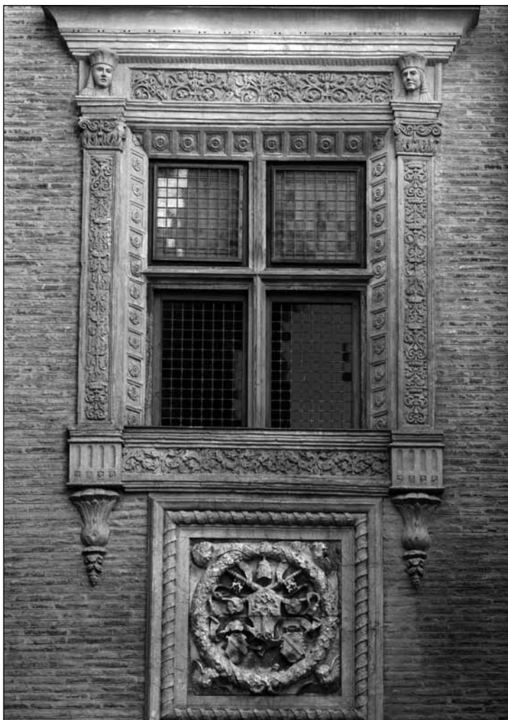
Figura 4. Palacio Decanal de Tudela. Detalle de la fachada.
