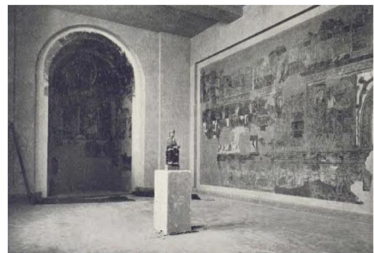
Obras en la sala de Santa Maria de Taüll del Museu d'Art de Catalunya en el Palau Nacional de Montjuïc y aspecto definitivo.
