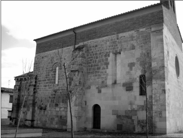
Encomienda de Cabanillas. Vista general del flanco norte. Puerta y ventana de comunicación entre iglesia y recinto. (Foto: Julia Baldó)
