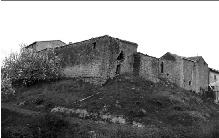
Encomienda de Echávarri. Vista general de frentes norte y occidental. (Foto: Julia Baldó).
