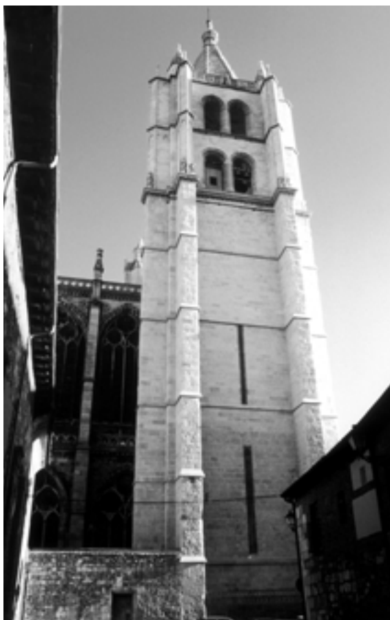
Fotografía 1. Torre de las Campanas de la Catedral, vista desde el norte.
