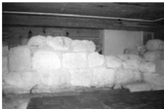
Figura 16. Aspecto del cierre del vano norte de la porta principalis sinistra.
