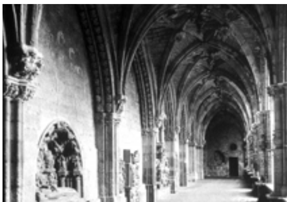
Figura 10. Catedral de León, interior del claustro
