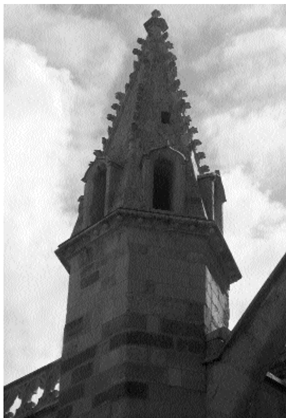
Lámina 5.- La Limona, detalle de la escalera y remate piramidal.
