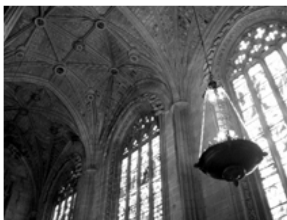
Lámina 18. Librería Capitulare. Detalle de las ventanas y arcos angrelados.
