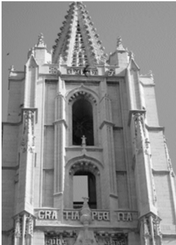
Lámina 12. Torre Sur; cuerpo de campanas y remate con la aguja calada.
