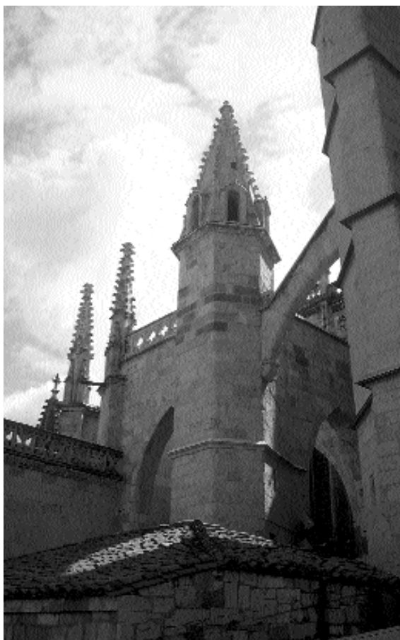
Lámina 4. Costado septentrional del transepto. La Limona, pantallas-contrafuerte del siglo XIII y remate del siglo XV.
