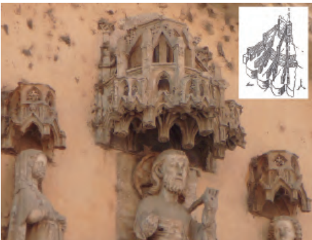
Fig. 8. Zaragoza. Iglesia de San Pablo, tabernáculo que protege la imagen del Salvador de la fachada septentrional, que presenta, como la solución adoptada en la catedral de Toledo, arbotantes divergentes en alzado.
