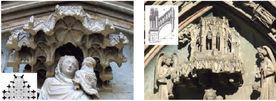
Fig. 12.1. Huesca. Catedral, tabernáculo que protege la imagen de la Virgen que preside el tímpano de la Puerta de los Apóstoles y la cabecera de la catedral de Wells; 12.2. Huesca. Catedral, alzado exterior con arbotantes de doble apeo como los de la catedral de Burdeos.
