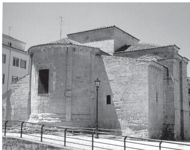
Figura 17. Iglesia de San Cristóbal (Salamanca). Exterior. Cabecera.
