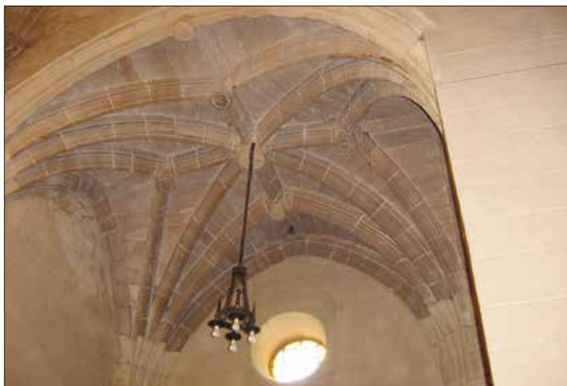
Interior de la capilla del lado de la epístola. Bóveda de crucería con terceletes del siglo XVI.
