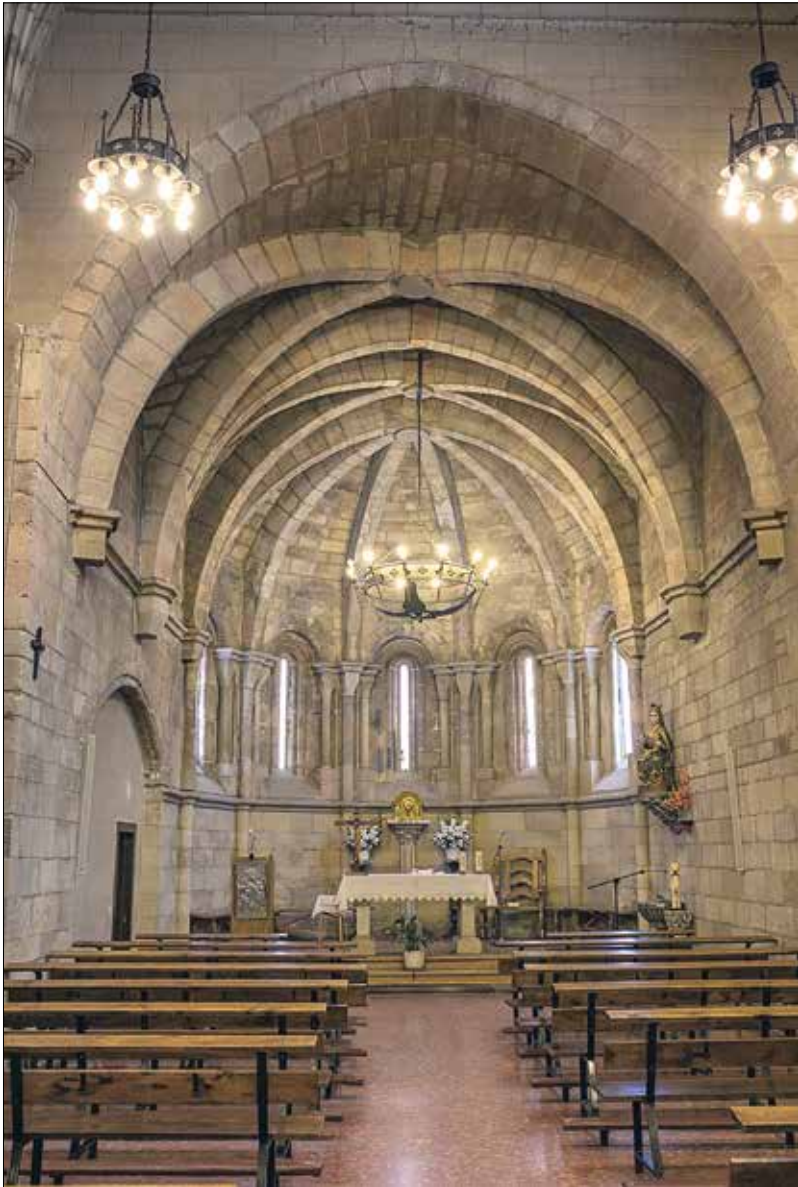
Ábside y presbiterio. Interior con bóveda de horno gallonada (foto Noelia Davia).
