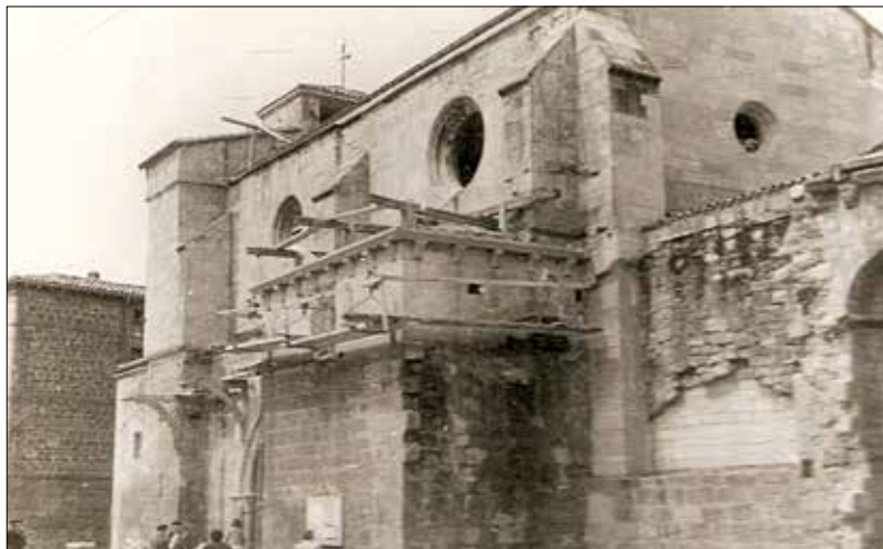
Fotografía de hacia 1966. La capilla de Nuestra Señora de la Soledad y el pórtico han sido derruidos y se está reconstruyendo la capilla de la nave.
