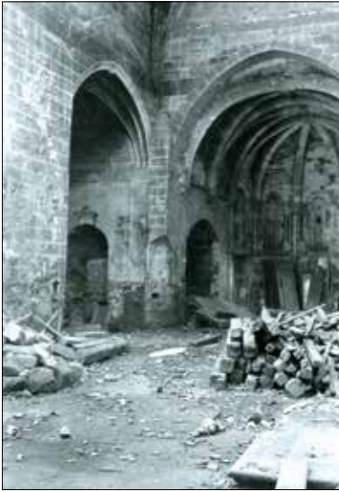
En el lado del evangelio de la iglesia se observa el arco del presbiterio y la capilla de la nave. Fotografía realizada tras el incendio de 1936.
