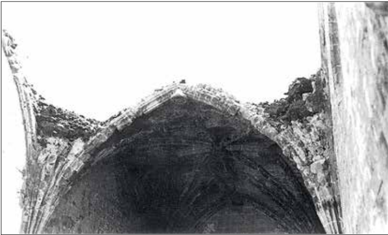
Bóveda de crucería de la nave (desaparecida). Fotografía realizada tras el incendio de 1936.
