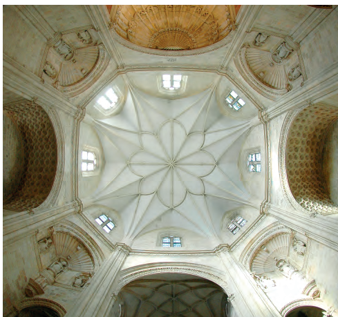
Fig. 10.16. Monasterio de La Vid (Burgos). Iglesia. Cabecera. Detalle del sistema de abovedamiento.
