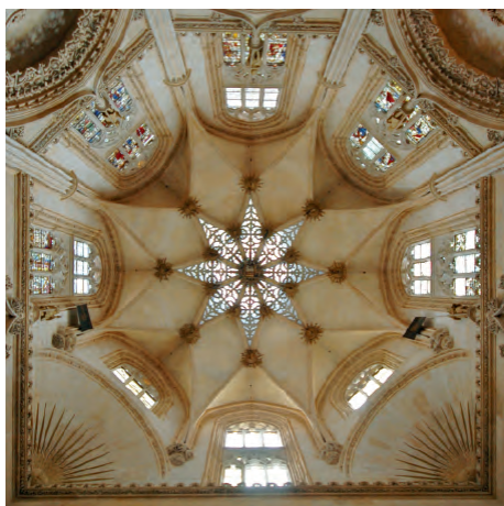
Fig. 3. Burgos. Catedral. Capilla del Condestable. Detalle del sistema de abovedamiento.
