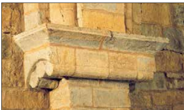
Lám. 381. Pamplona, antiguo palacio episcopal de San Jesucristo, capilla, ménsula nave
