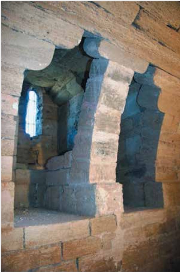
Lám. 219. Monasterio de Irache, iglesia abacial, torre, sala del primer piso, vano norte
