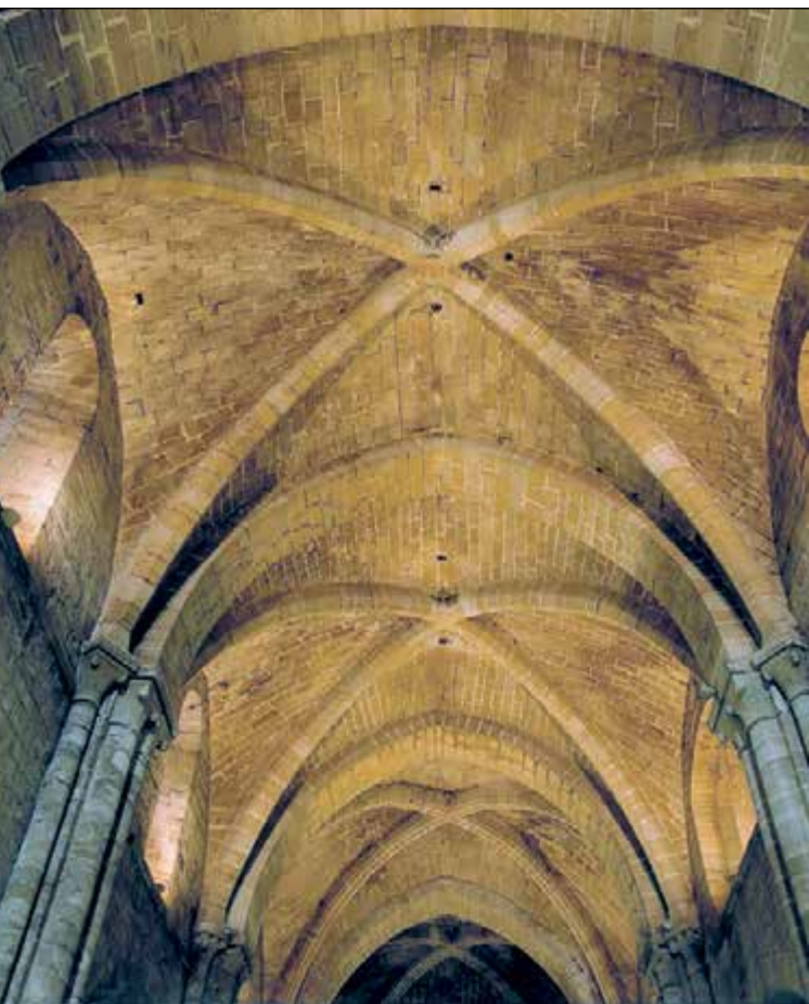
Lám. 37. Monasterio de la Oliva, bóvedas de la nave mayor
