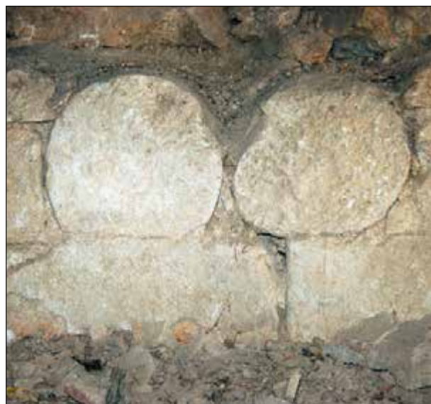
Lám. 208. Monasterio de Irache, iglesia abacial, sillares cilíndricos del muro sur de la nave mayor
