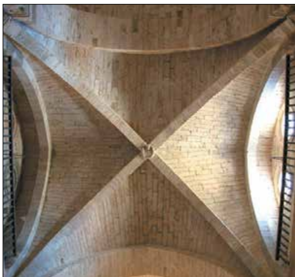
Lám. 207. Monasterio de Irache, iglesia abacial, bóveda del tramo intermedio de la nave mayor
