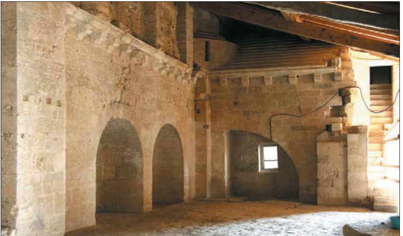
Lám. 195. Monasterio de Irache, iglesia abacial, paramentos meridionales crucero y primer tramo de la nave mayor
