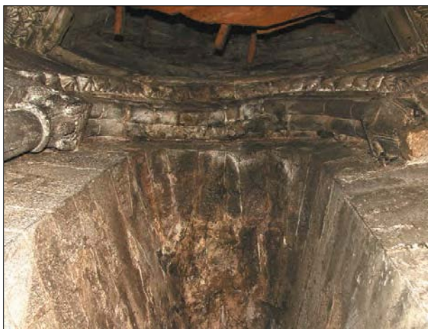
Lám. 343. Sangüesa, Santiago, presbiterio, vano y semicolumnas adosadas del ábside tras el retablo
