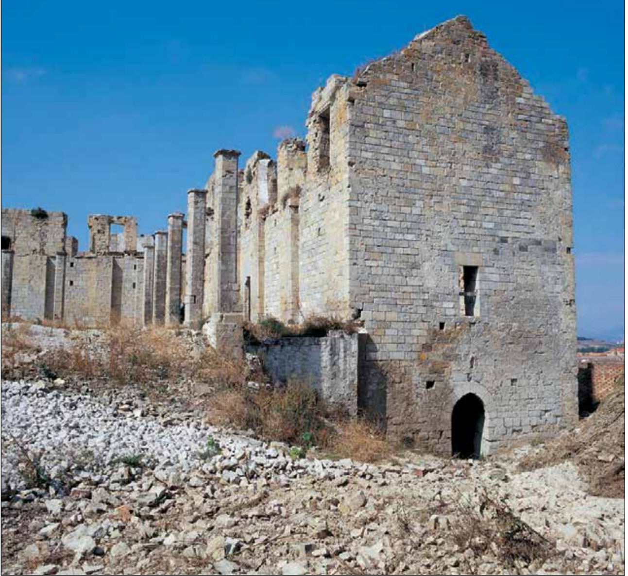
Lám. 388. Pamplona, antiguo palacio real (hoy Archivo General), exterior ala norte con la puerta al semisótano
