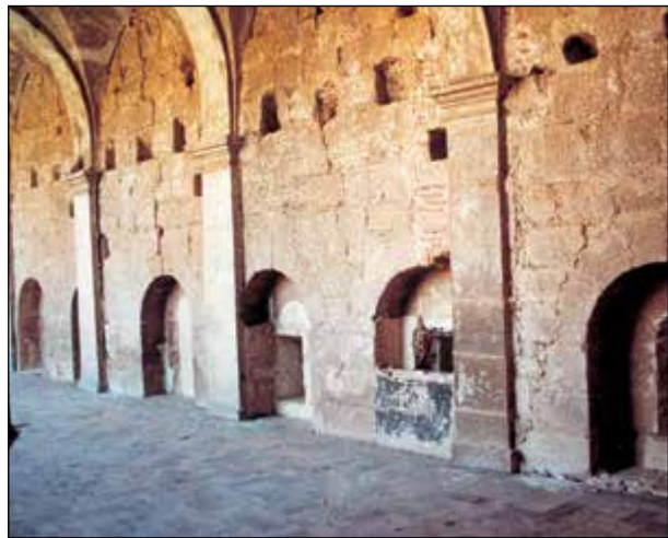
Lám. 86. Fitero, monasterio de Santa María, línea de ventanas del dormitorio
