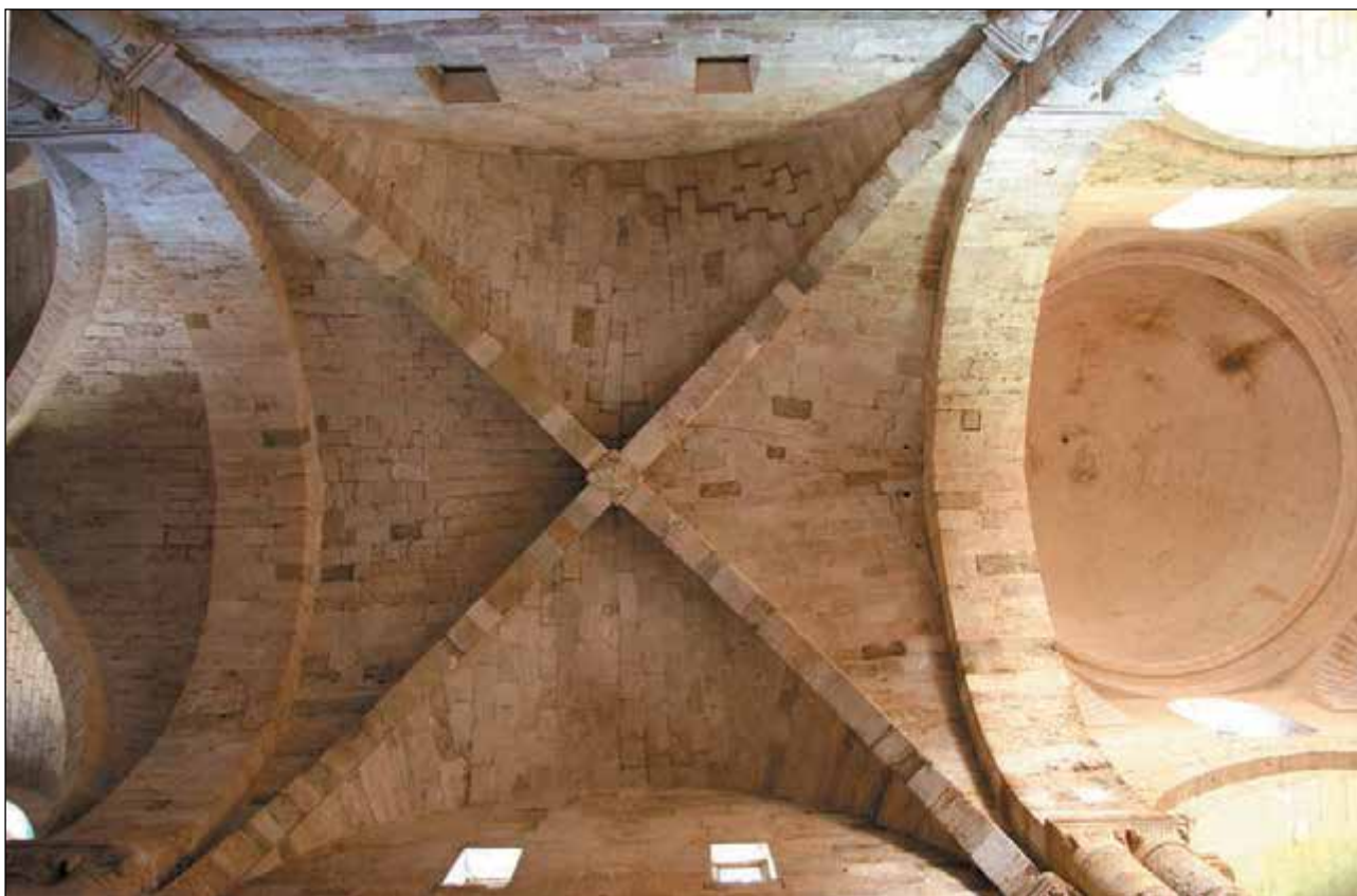
Lám. 18. Monasterio de Irache, bóveda de la nave mayor
