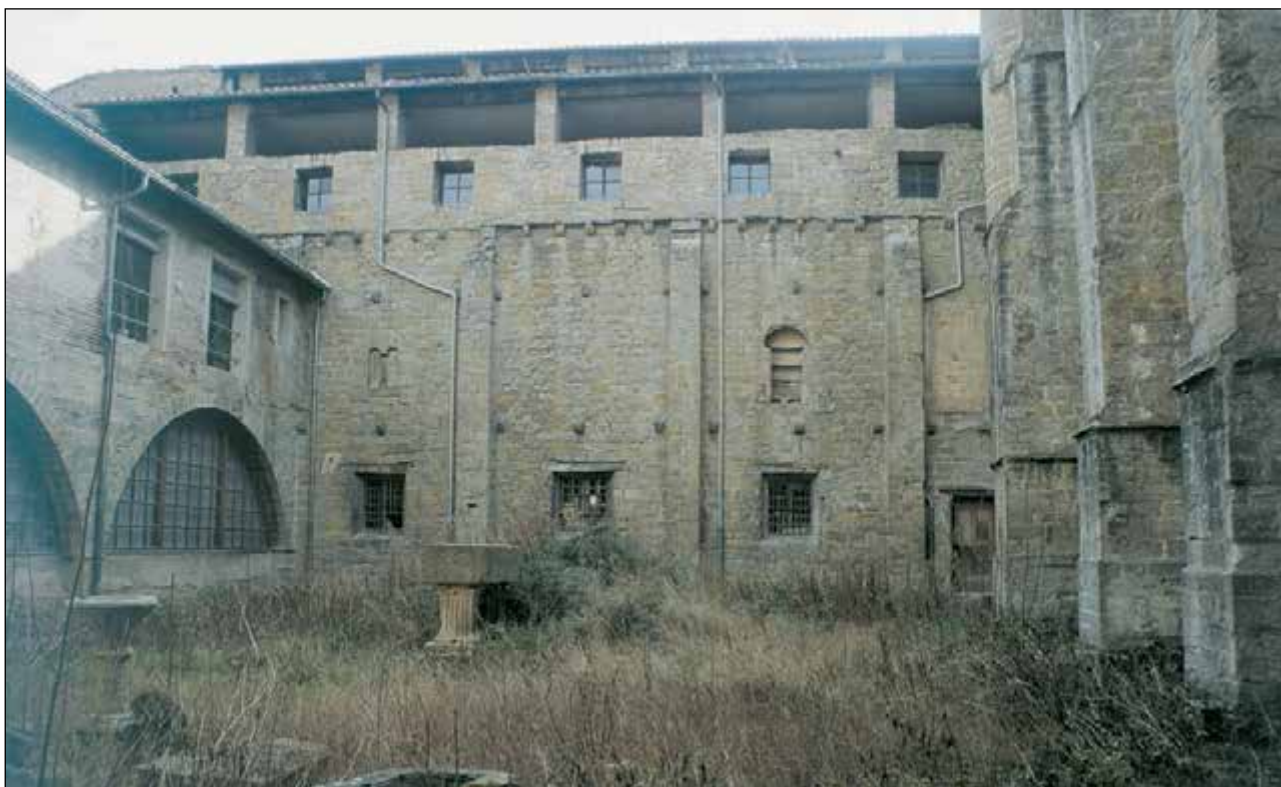
Lám. 375. Pamplona, antiguo palacio episcopal de San Jesucristo, fachada norte
