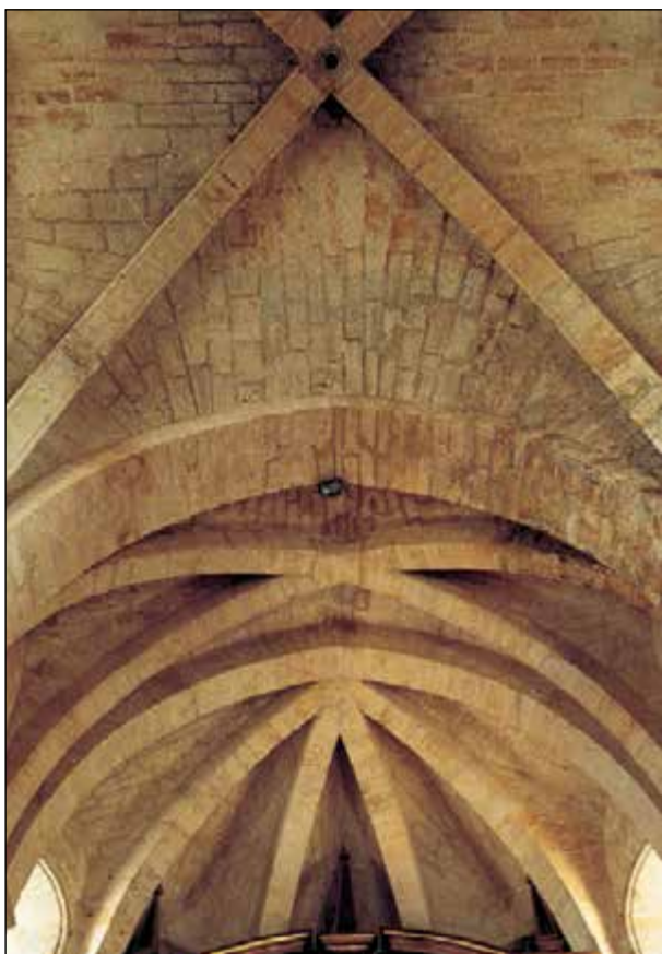
Lám. 40. Fitero, monasterio de Santa María, bóvedas del presbiterio
