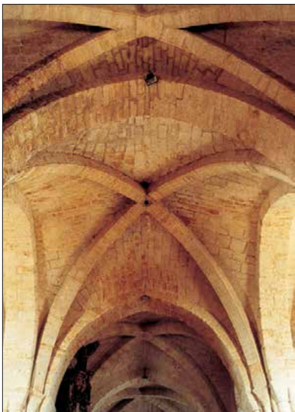
Lám. 19. Fitero, monasterio de Santa María, bóveda central del crucero
