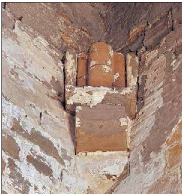
Lám. 387. Pamplona, antiguo palacio real (hoy Archivo General), arranque de los nervios de la bóveda de la torre
