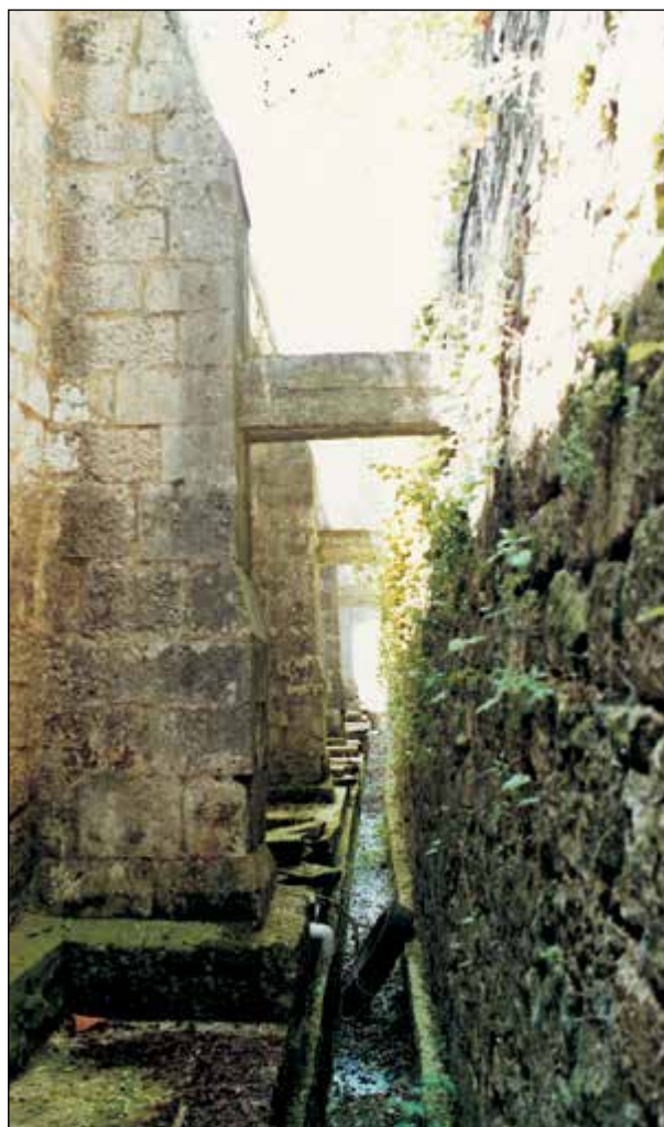
Lám. 143. Monasterio de Iranzu, iglesia abacial, muro septentrional y refuerzo de la ladera
