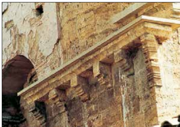
Lám. 73. Fitero, monasterio de Santa María, exterior del crucero sur, detalle canecillos
