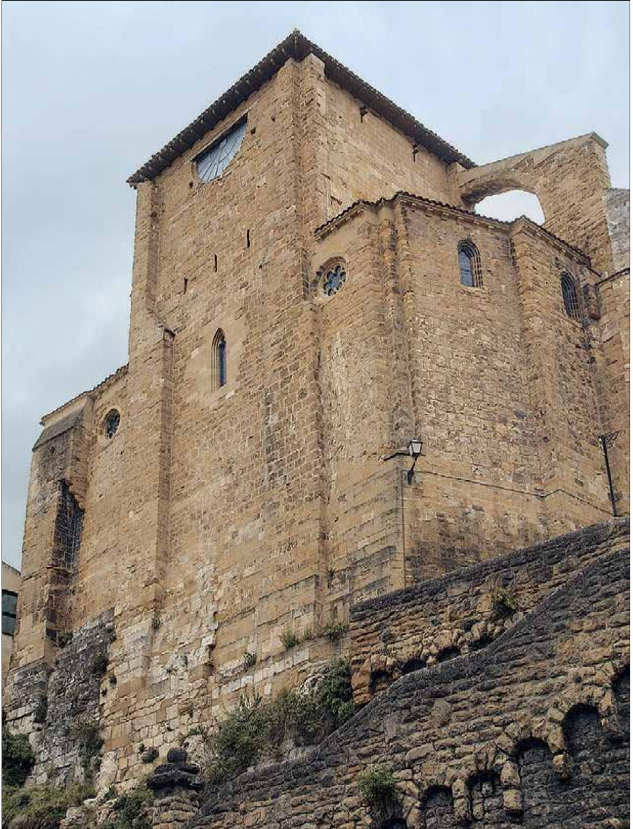
Lám. 316. Estella, San Miguel, fachada occidental
