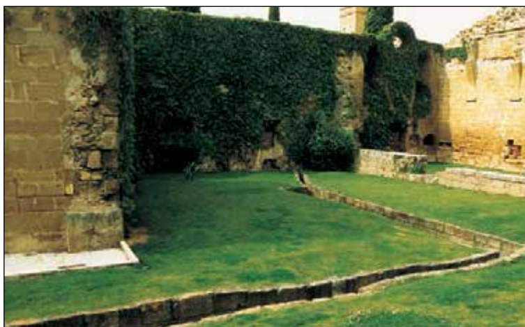
Lám. 127. Monasterio de la Oliva, canalizaciones de agua del ala del refectorio
