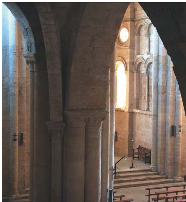
Lám. 11. Monasterio de Irache, capilla mayor desde la nave norte
