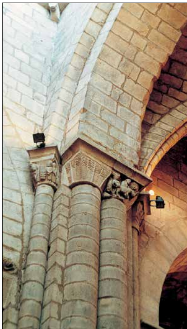
Lám. 337. Sangüesa, Santa María, nave mayor, pilar toral suroccidental
