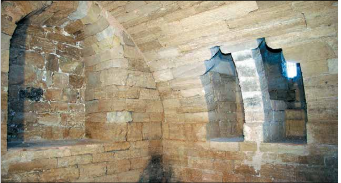
Lám. 218. Monasterio de Irache, iglesia abacial, torre, sala del primer piso hacia el noroeste
