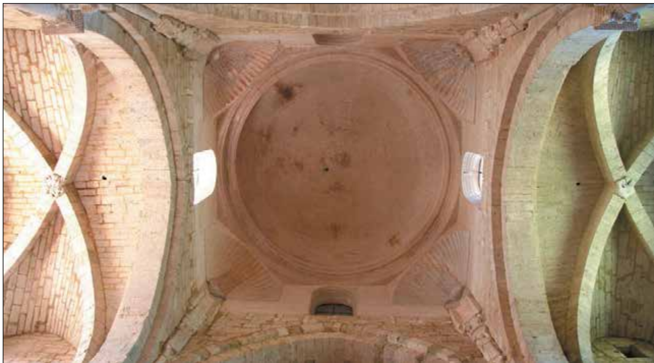
Lám. 212. Monasterio de Irache, iglesia abacial, cimborrio con las bóvedas del crucero
