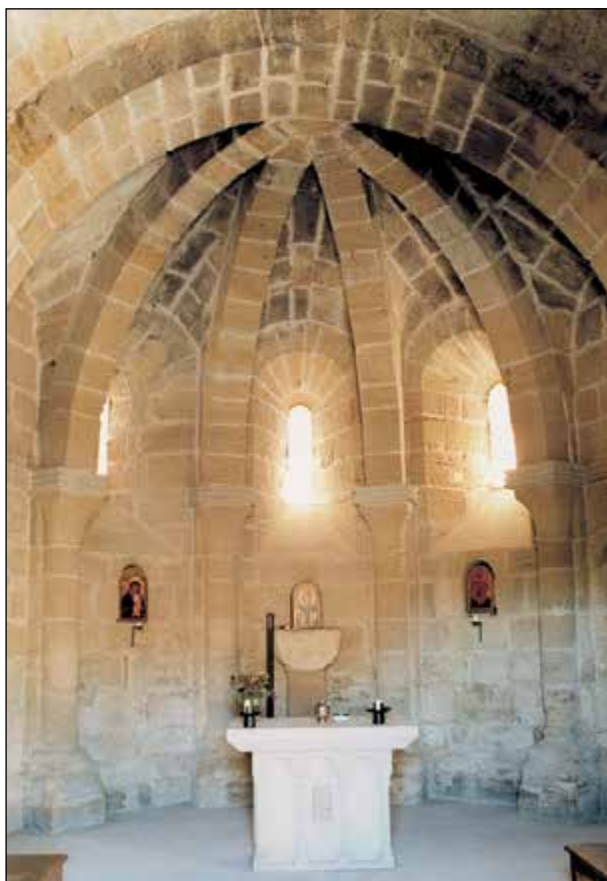
Lám. 128. Monasterio de la Oliva, capilla de San Jesucristo, interior
