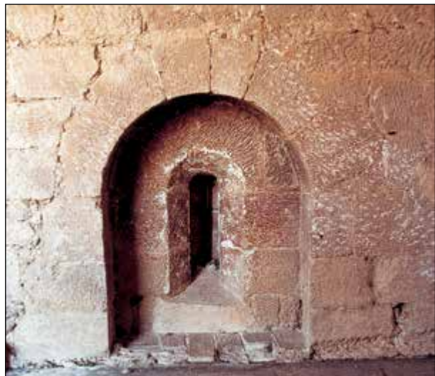
Lám. 87. Fitero, monasterio de Santa María, ventana del dormitorio
