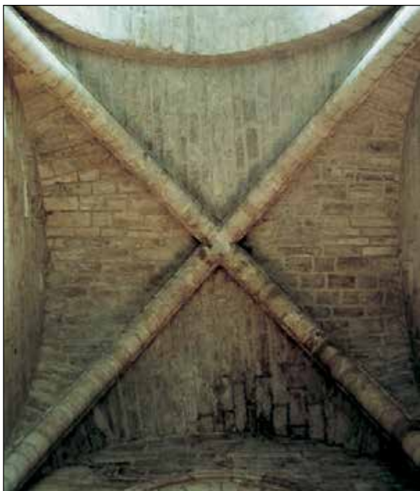
Lám. 245. Tudela, catedral de Santa María, bóveda capilla extrema septentrional
