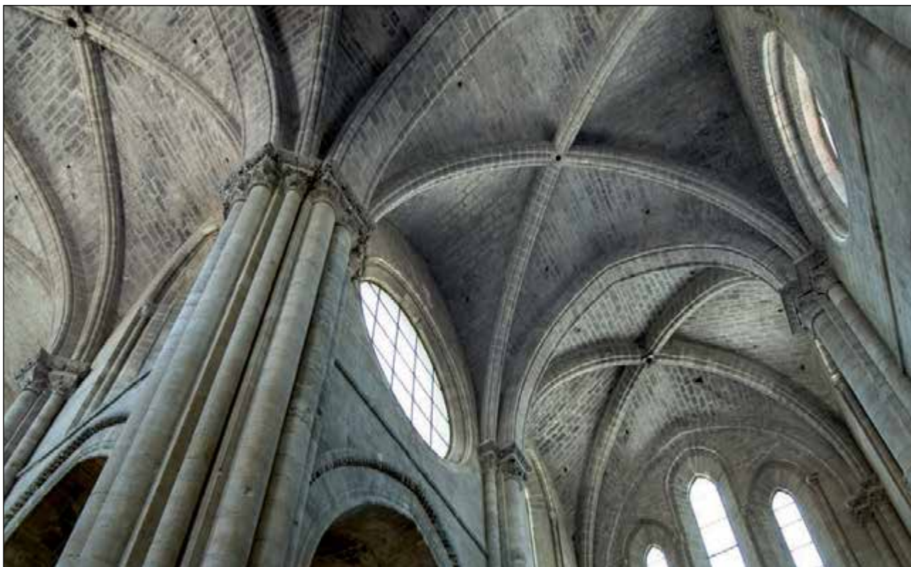
Lám. 253. Tudela, catedral de Santa María, bóvedas del crucero y pilar toral
