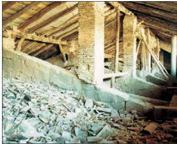
Lám. 84. Fitero, monasterio de Santa María, dormitorio, vista superior de los arcos diafragma
