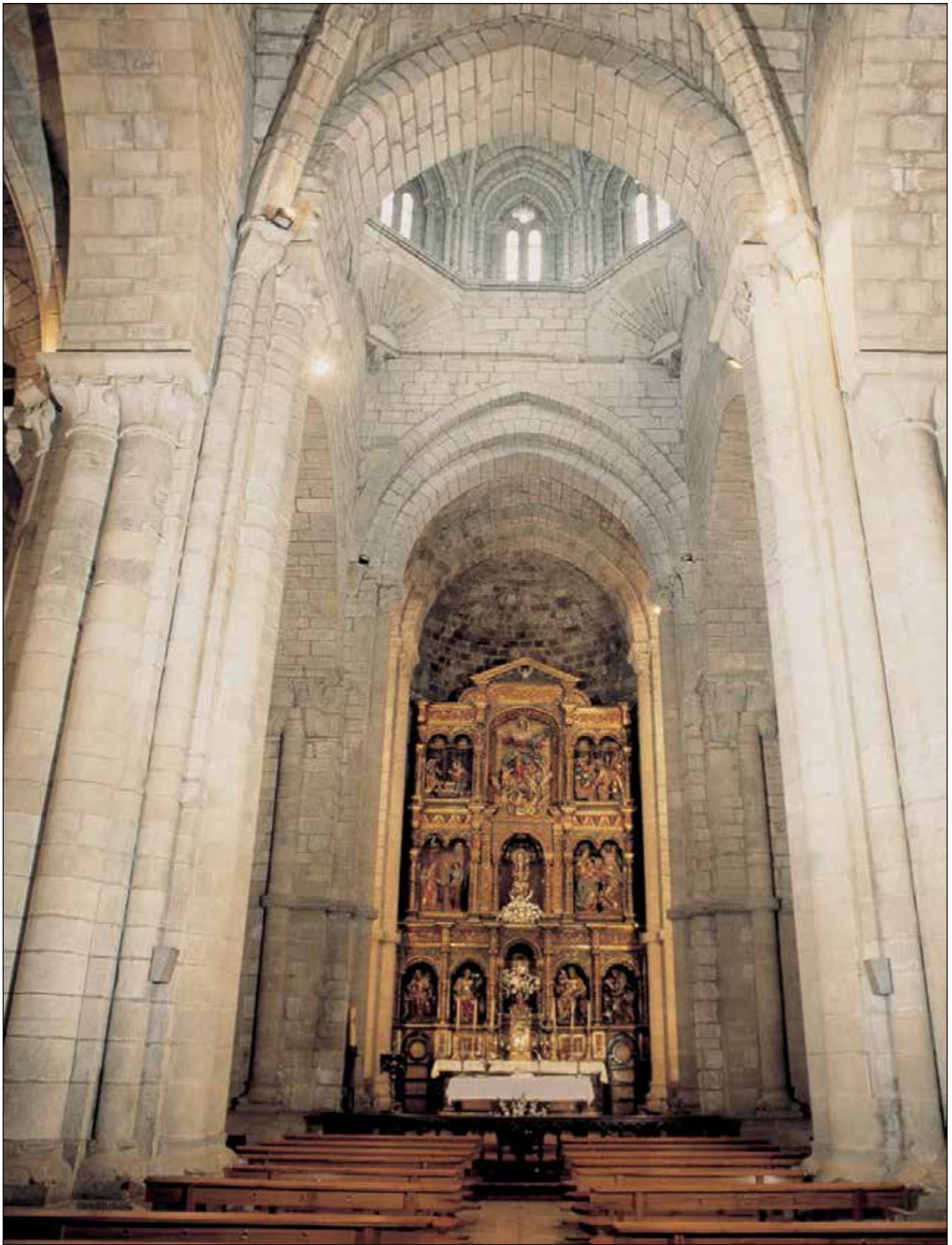
Lám. 332. Sangüesa, Santa María, cimborrio y presbiterio desde la nave mayor
