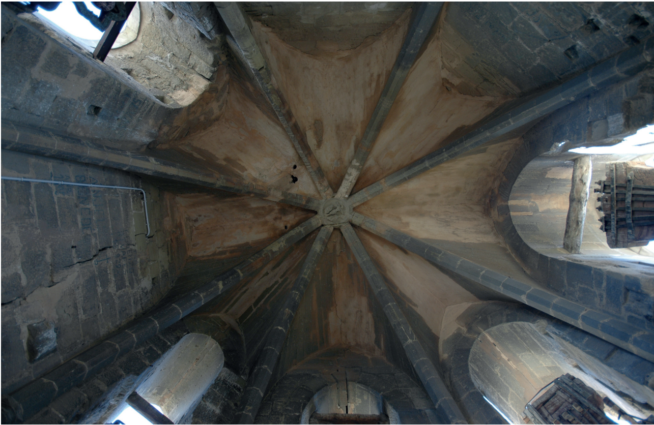
Fig. 11. Huesca. Catedral. Detalle del sistema de abovedamiento del último piso de la torre. Foto: Javier Ibáñez Fernández.
