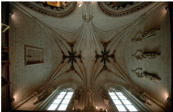
Fig. 16. Tordesillas (Valladolid). Monasterio de Santa Clara. Capilla Saldaña. Detalle del sistema de abovedamiento. Foto: Javier Ibáñez Fernández.
