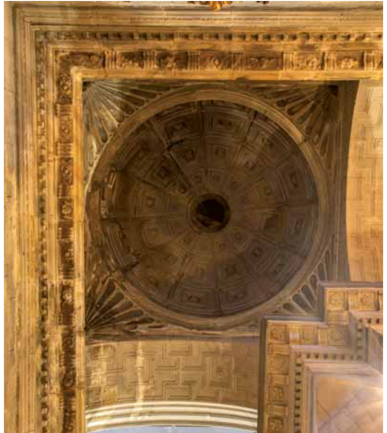
Cúpula casetonada de una de las capillas de la cabecera (Fotografía: Andoni San Juan).
