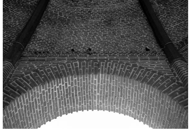
Figura 12. Detalle del arco donde se asienta la cúpula mostrando su curvatura sobre una de las caras del octágono. Fotografía de Fredy Ovando Grajales.
