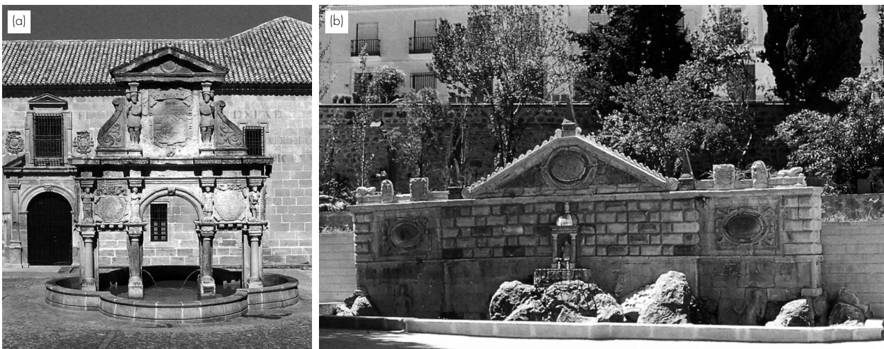
Figura 16. (a) Fuente de Santa María en Baeza (1564). (b) Fuente del Rey en Priego de Córdoba (1568-1585). Fotografías tomadas de Felipe II: Los ingenios y las máquinas: ingeniería y obras públicas en la época de Felipe II , escrito por Real Jardín Botánico (España), Sociedad Estatal para la Conmemoración de los Centenarios de Felipe II y Carlos V. Sociedad Estatal para la Conmemoración de los Centenarios de Felipe II y Carlos V, 1999.
