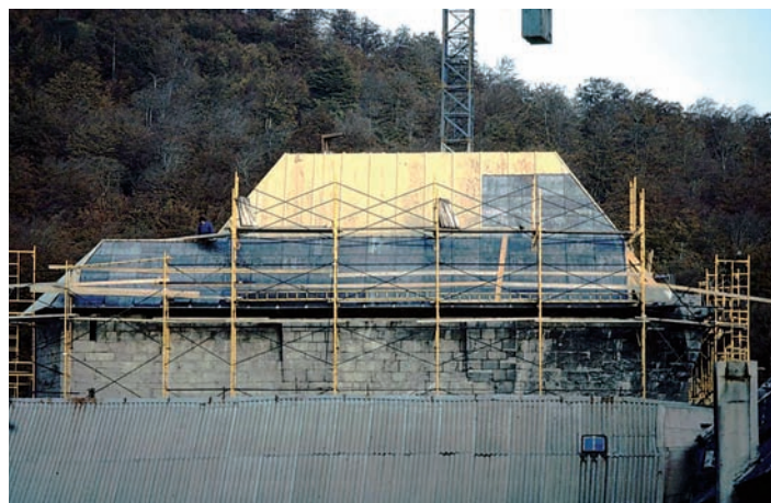
El tejado de la capilla de San Agustín, en restauración 1983
