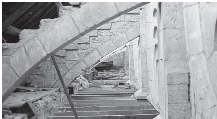
Estado inicial de la cubierta: rosetones y arbotantes
