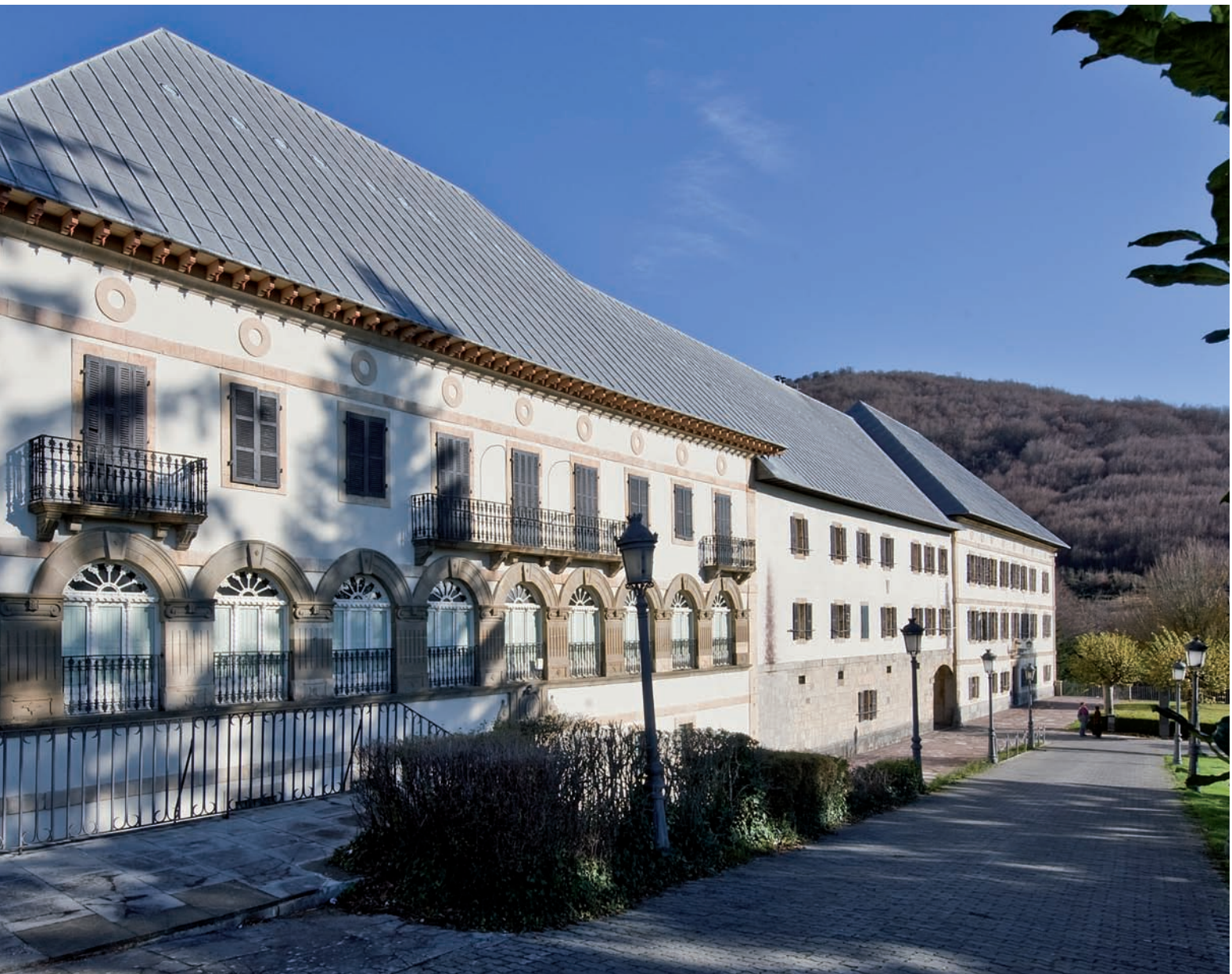
Biblioteca (actual museo) y casa prioral: fachada meridional
