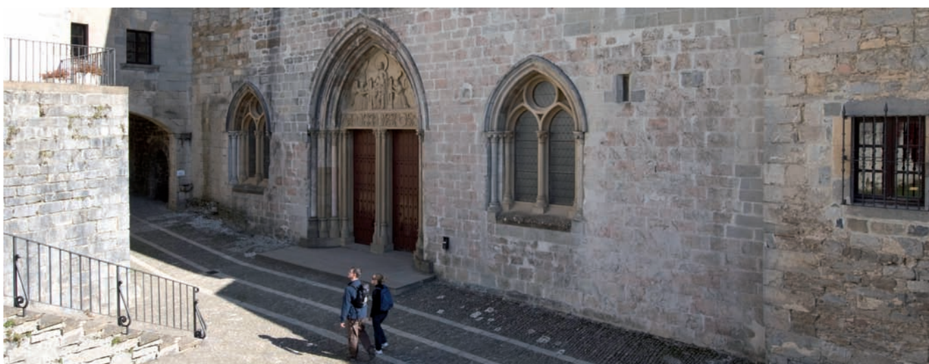
Fachada occidental de la iglesia de Santa María
