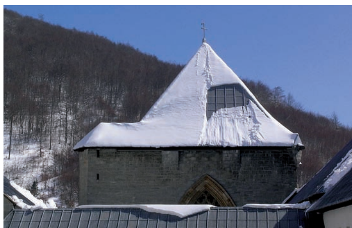
El tejado de la capilla de San Agustín, restaurado
