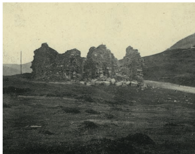
Ruinas de edificios en Ibañeta antes de su reconstrucción
