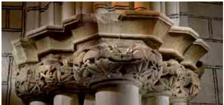
Capitel de la pilastra P-4-N
