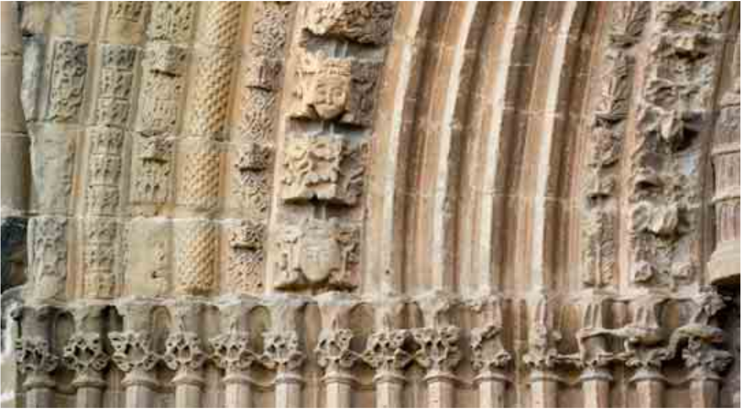
Detalle de las arquivoltas de la portada occidental
