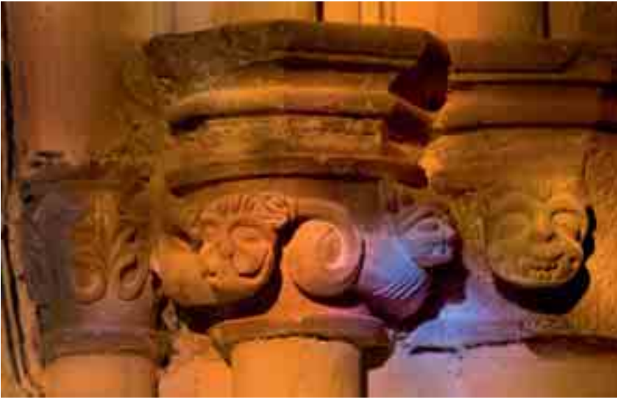
Capitel de la pilastra P3-N
