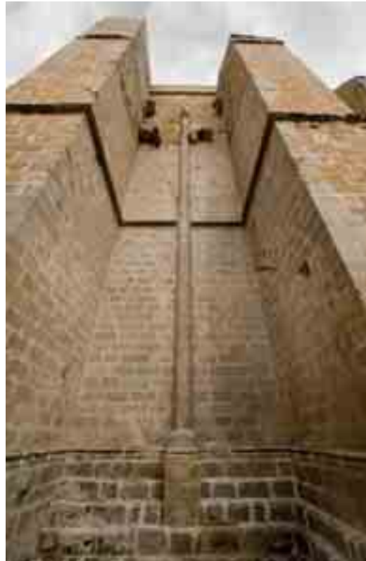
Detalle de la conducción de agua en el tramo occidental de la fachada meridional
