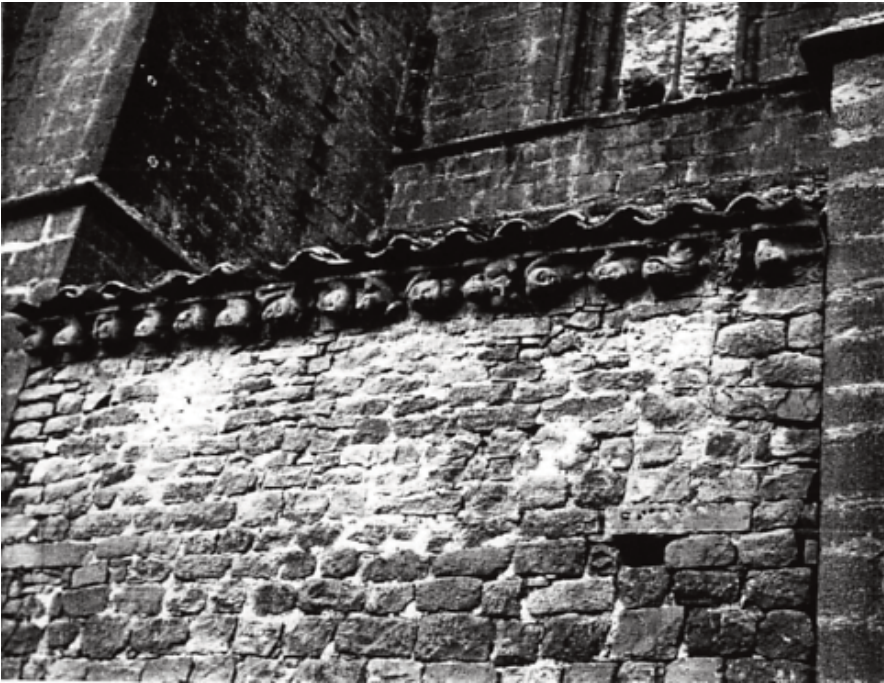
Elementos de la portada septentrional integrados en la capilla del Cristo antes de su restauración
