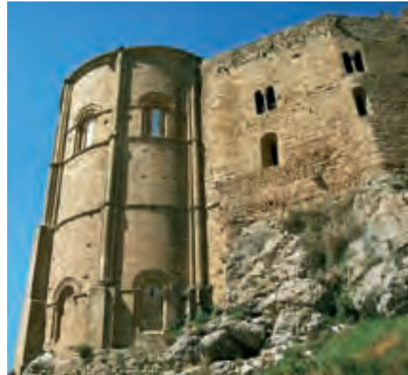
Fig. 10. San Pedro de Loarre. Cabecera (Foto: Carlos Villasante)
