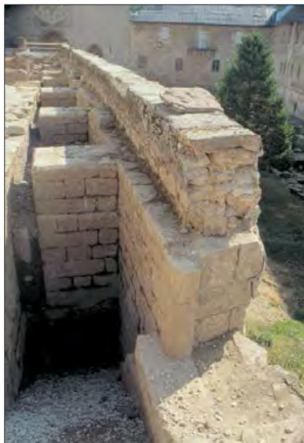
Roncesvalles, muro del antiguo hospital ("la Caritat")
