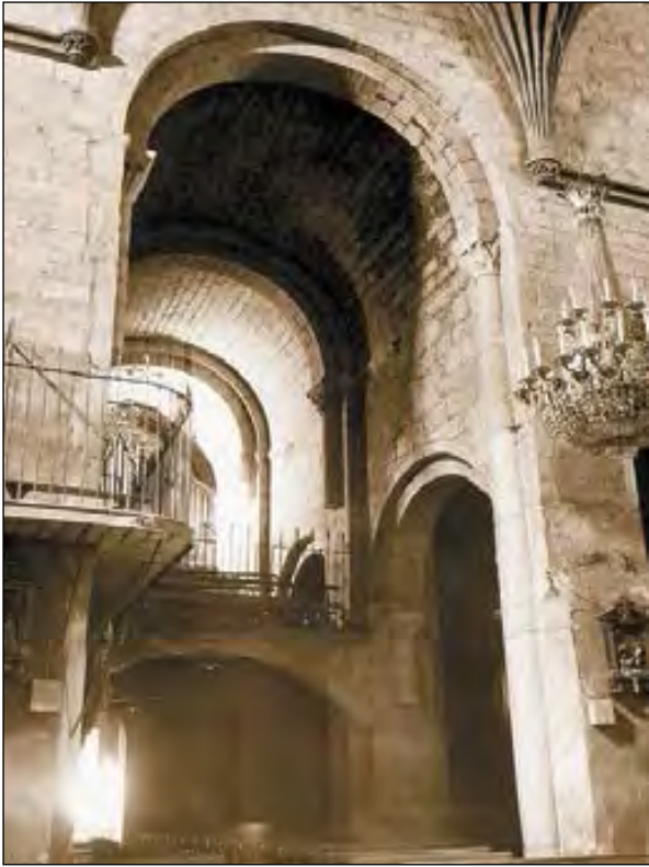
Aibar, San Pedro, vista interior de las naves románicas
