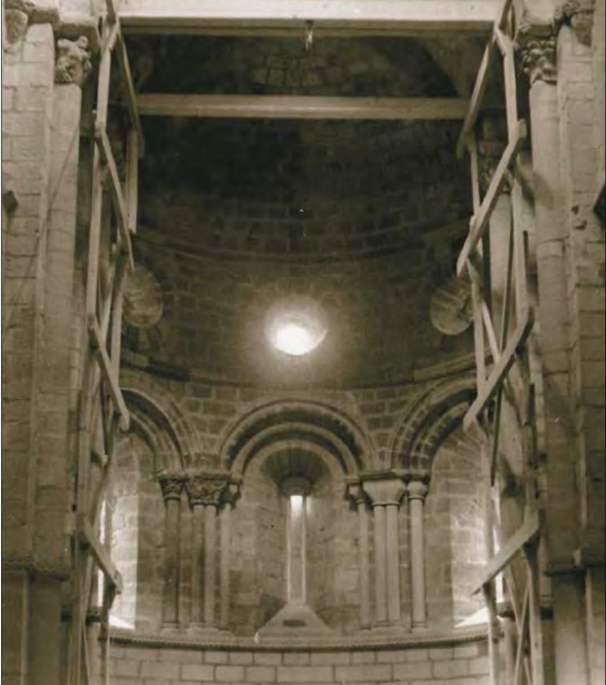
Sangüesa, Santa María, interior del ábside durante la restauración
