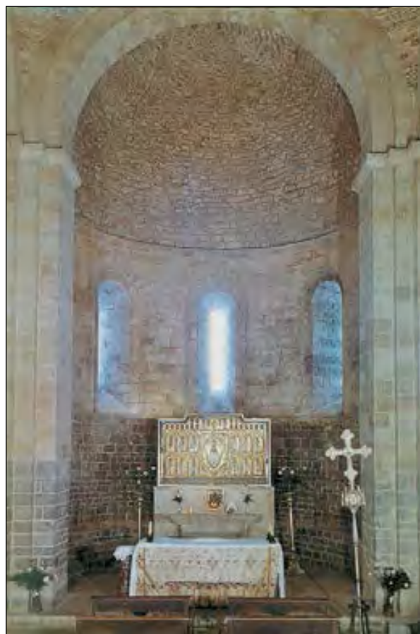
San Miguel de Aralar, interior del ábside central
