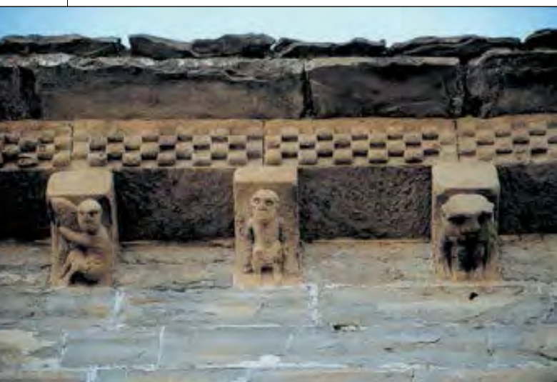
Navascués, Santa María del Campo, detalle de los canecillos de cornisa
