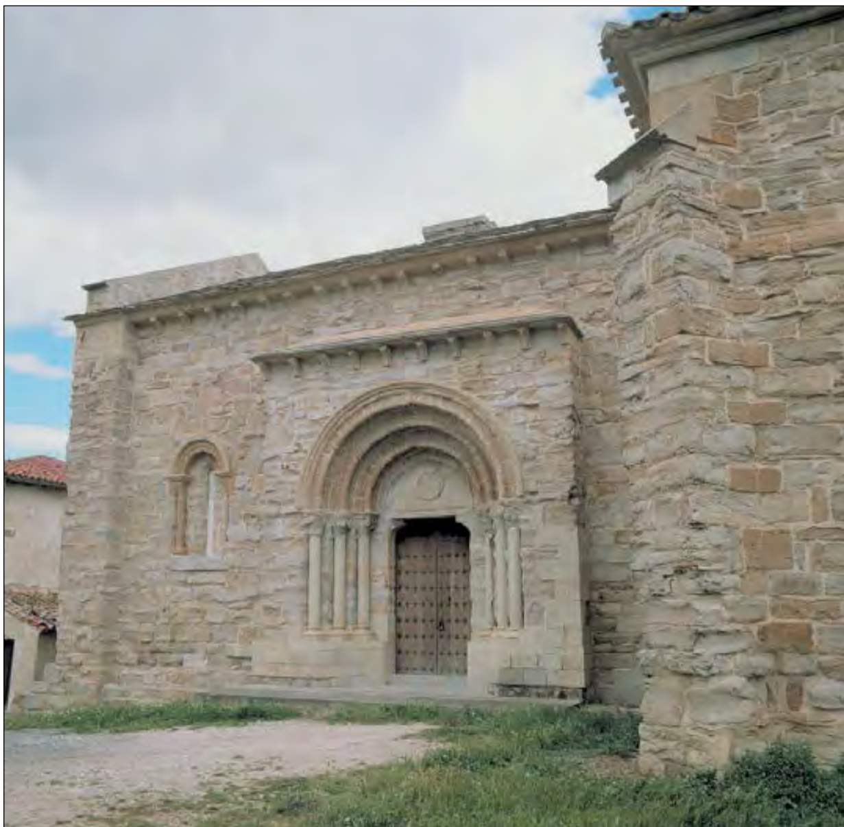
Cizur Menor, antigua encomienda sanjuanista, exterior
