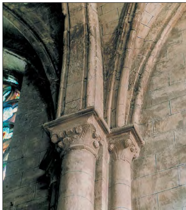
Estella, San Pedro de la Rúa, soporte de la nave de la epístola
