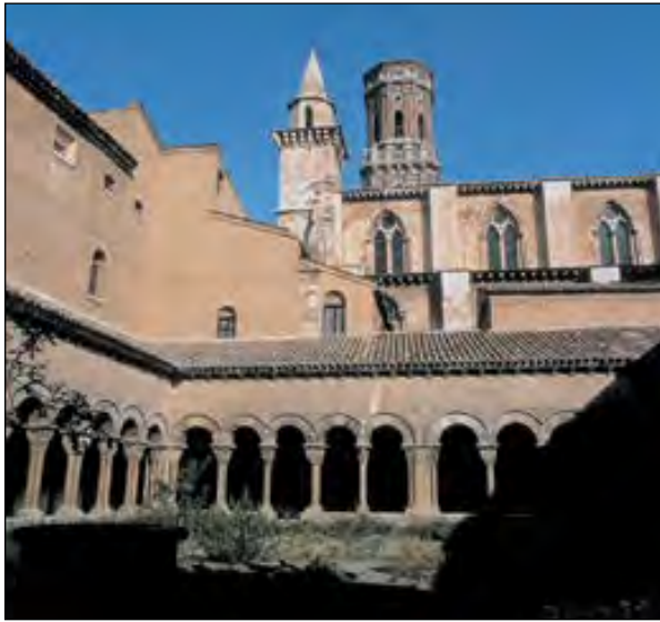
Tudela, catedral de Santa María, claustro y parte occidental de las naves
