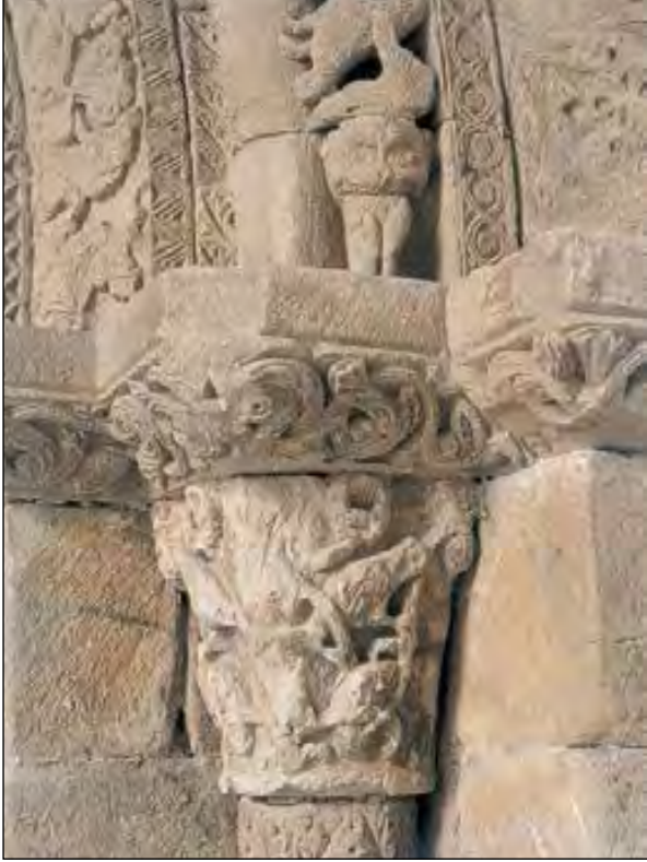
Puente la Reina, El Crucifijo, detalle de la portada meridional
