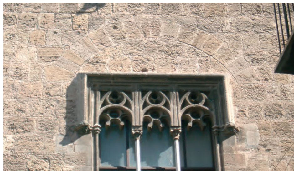
Detalle del arco de descarga de una ventana del palacio Abatellis de Palermo, Sicilia.
