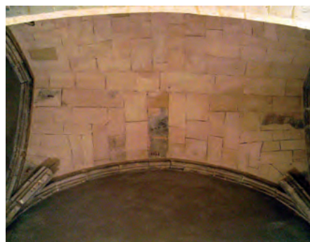
Bóveda de crucería con nervios desaparecidos de una capilla de la cabecera de la iglesia del convento de Santo Domingo de Cagliari, Cerdeña.
