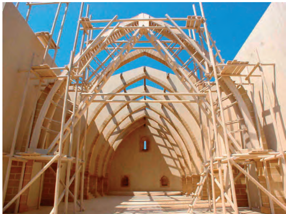
Maqueta, realizada por Carlos Martínez, de la iglesia parroquial en construcción de Olocau del Rey, Comunidad Valenciana.
