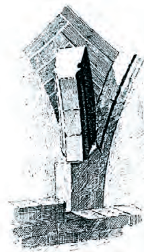
Bóveda con aparejo concertado y nervios arruinados en el castillo templario de Tartus, Siria, según Camille Enlart en Monuments des Croisés dans le royaume de Jérusalem.
