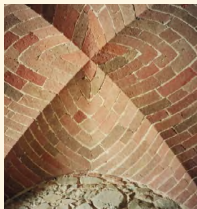
Bóveda aristada de ladrillo cortado en la cartuja de Montalegre, cerca de Barcelona.
