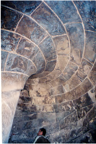
Escalera con bóveda helicoidal dispuesta a modo de "vis de Saint Gilles" en la puerta de las Victorias de El Cairo. (Foto F. Vegas y C. Mileto).
