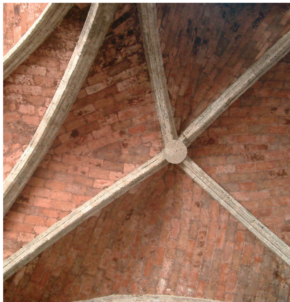
Bóveda de crucería con plementería tabicada en el claustro del convento de Santo Domingo de Valencia.
