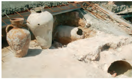
Cerámicas de la bóveda de una capilla de la parroquia vieja en Vilafamés, Comunidad Valenciana.
