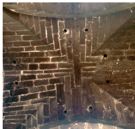
Bóveda de arista en el campanario de la iglesia de santa María del Almirante, llamada "La Martorana", Palermo, Sicilia.
