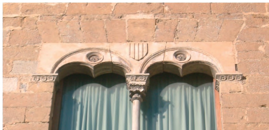
Detalle del arco de descarga, plano, de una ventana de la sala del ayuntamiento de Morella, Comunidad Valenciana.
