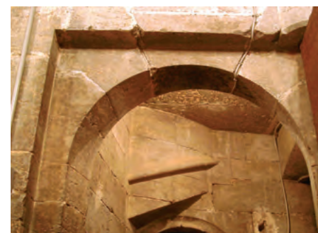
Arco oblicuo del interior de la sacristía de la capilla real de Valencia con aparejo compensado.
