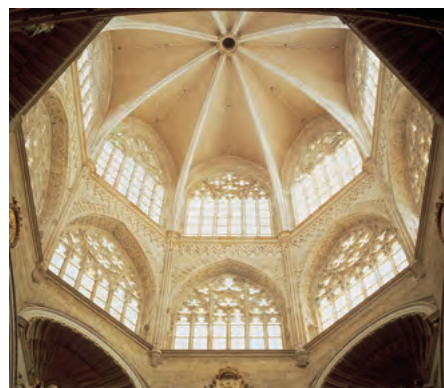
Bóveda del cimborrio de la catedral de Valencia.
