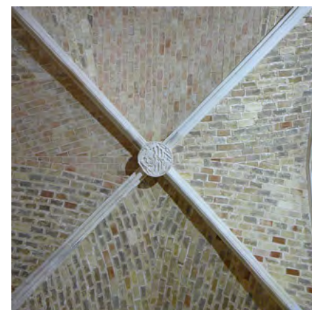
Bóveda de la torre de los Cabrera en Pozzalo, Sicilia.
