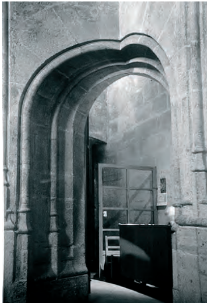
Arco "en rincón" en el acceso a la torre del Miguelete en la catedral de Valencia.
