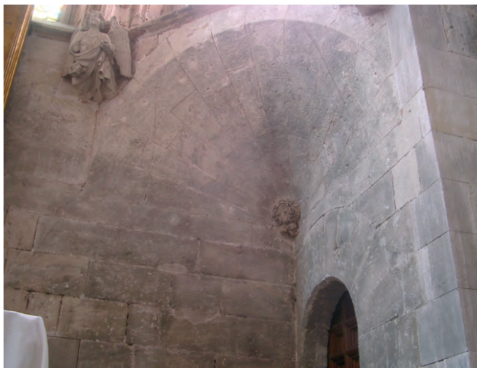
Trompa de la capilla de la Trinidad de la catedral de Palma de Mallorca.
