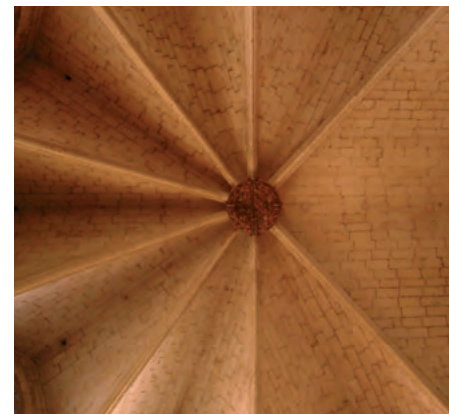
Bóveda de crucería de rampante llano y plementería pétrea de la iglesia conventual de San Francisco en Palma de Mallorca.
