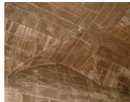
Bóveda de la sacristía de la capilla real del convento de Santo Domingo de Valencia.
