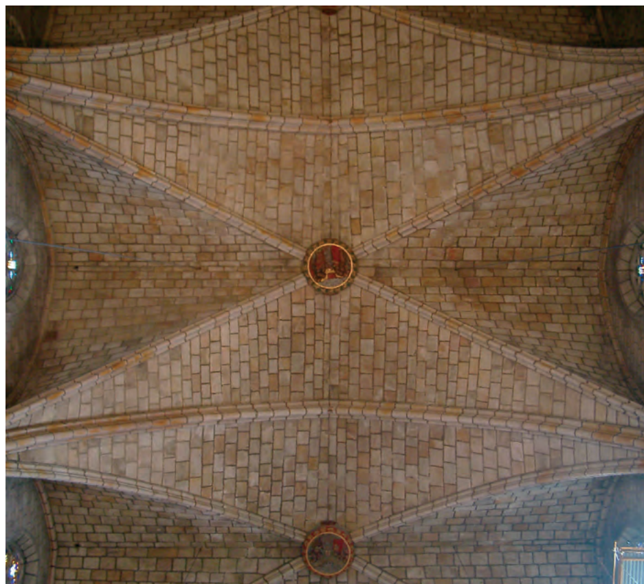
Bóveda de crucería de rampante llano y plementería pétrea de la iglesia conventual de Santa María de Pedralbes en Barcelona.
