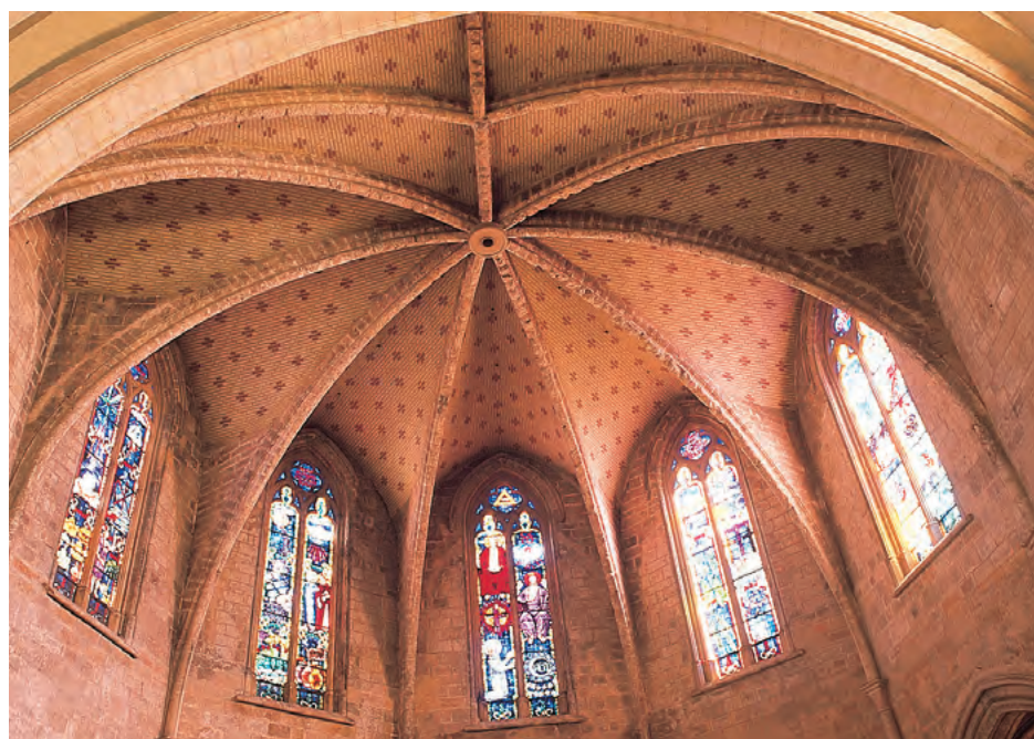
Bóvedas con plementerías de ladrillo dispuesto a rosca en la iglesia del Salvador de Burriana. (Foto P. Balaguer-L. Vicén).
