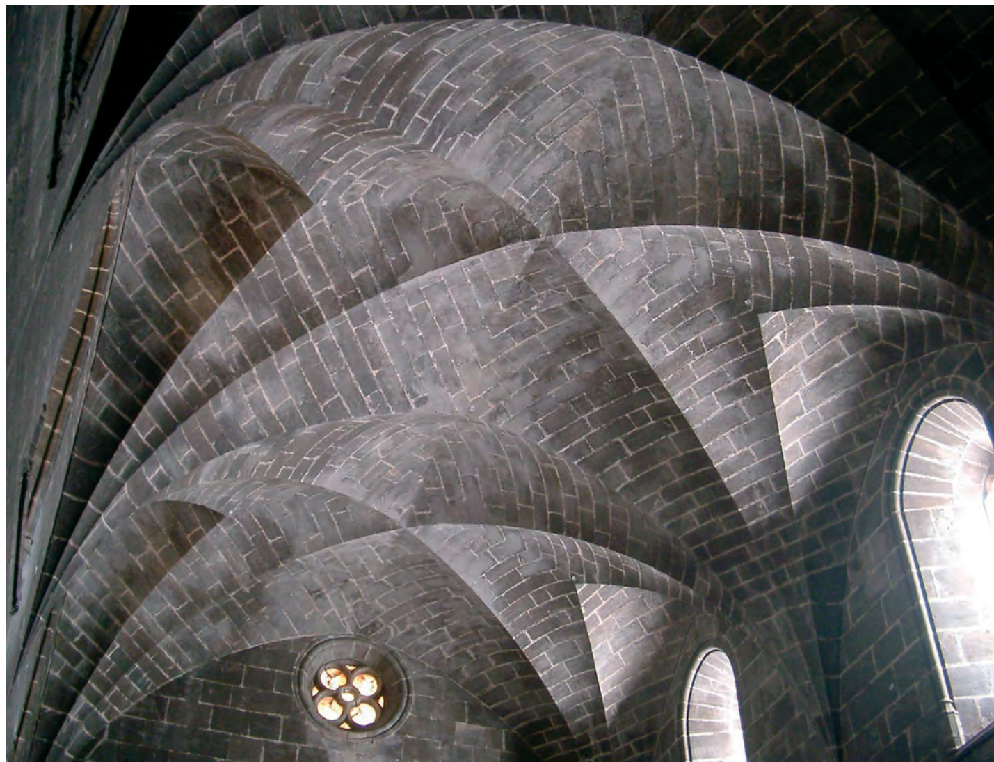
Bóveda de la capilla real del convento de Santo Domingo de Valencia.
