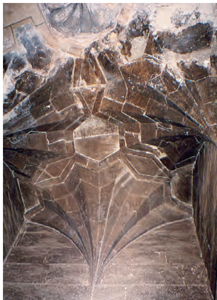
Bóveda aristada o plegada en la wikala del sultán Qaytbay en El Cairo. (Foto F. Vegas y C. Mileto).
