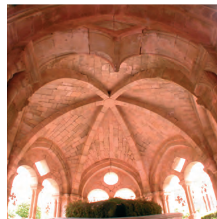
Bóveda del lavabo del claustro del monasterio cisterciense de Santes Creus, Cataluña.
